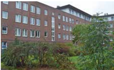
04 Unsere Wohnanlagen: VE 30 in Altona-Nord
