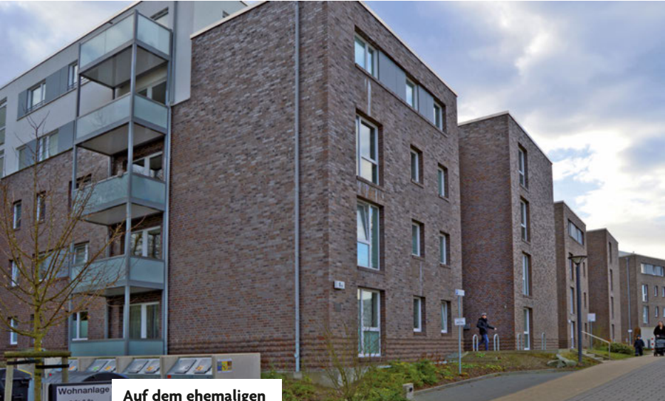
Auf dem ehemaligen Teilgelände von Studio Hamburg wurden die Wohnanlagen der Genossenschaften Lehrerbau und 1902 aus dem Boden gestampft.
