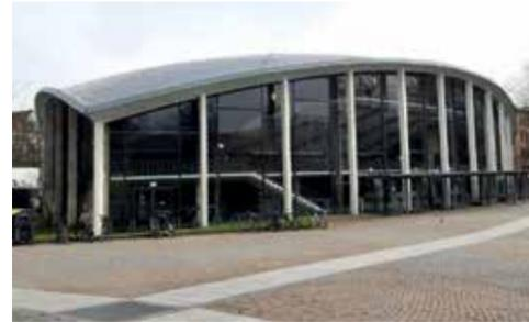
durch aus, dass seine Stahl-Glas-Konstruktion im Inneren frei von tragenden Elementen ist.
