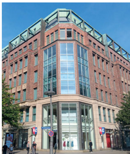
Das „Südseehaus“ wurde 1958 grundlegend saniert.
